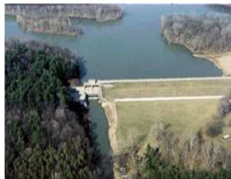
Lavori di Geotecnica
