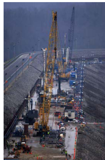
Lavori sulla piattaforma – Wolf Creek
